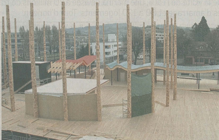
Le pavillon vaudois, aujourd'hui en construction, n'a de loin pas fait l'unanimité des communes du district de Nyon.
